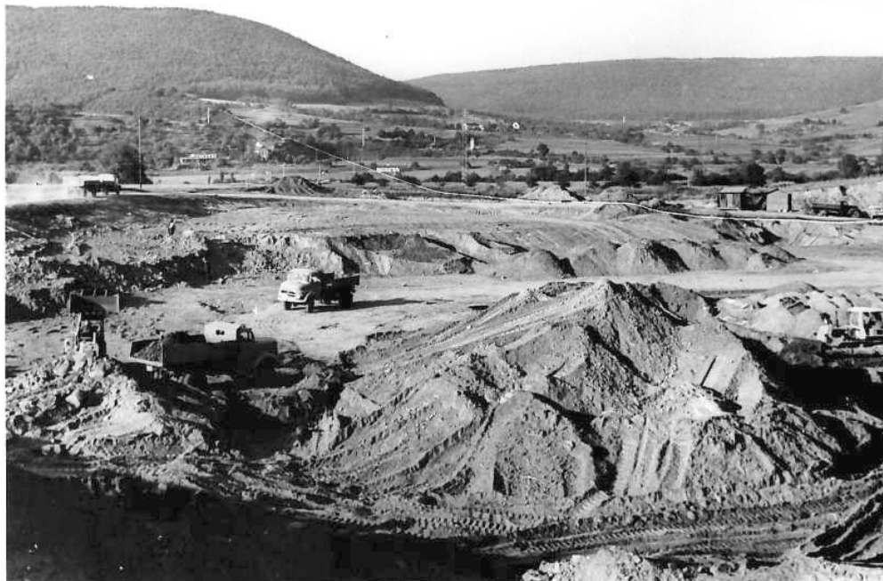
Zwei Bilder aus der Bauphase
